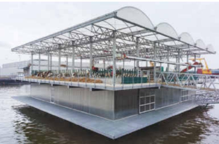
Die Leichtbaukonstruktion folgt den Erfordernissen mit offener Stallfläche und transparent umschlossener Molkerei. Unter der Wasserlinie die technischen Anlagen.
