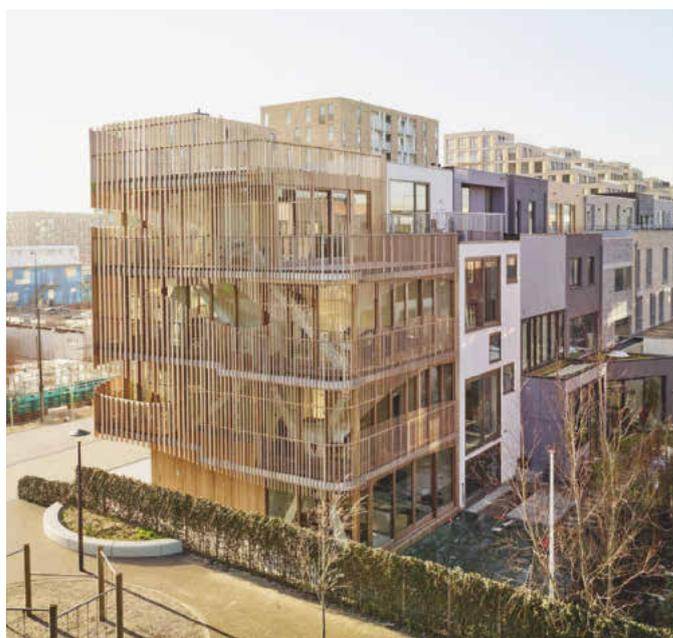
Allein schon durch die vorgehängte Fassade aus Riesenzeder-Lamellen unterscheidet sich der ‚Freebooter‘ von der Wohnbebauung in der Umgebung.
