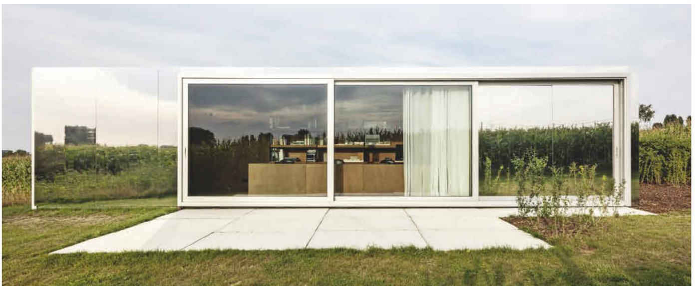
‚Cowes‘, der zweite Container-Büropavillon, steht auf einem Grundstück in Westouter. Die Architekten versuchten, ein Büro zu schaffen, das so unsichtbar wie möglich ist und die Landschaft sprechen lässt. Durch die Außenverkleidung mit spiegelnden Aluminiumpaneelen wird die Umgebung aus jedem Winkel reflektiert.
